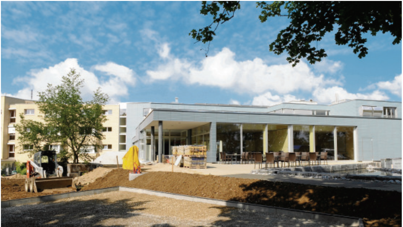
Das erneuerte Schönbühl von Osten aus gesehen. Im Vordergrund entsteht noch ein Spielplatz.
